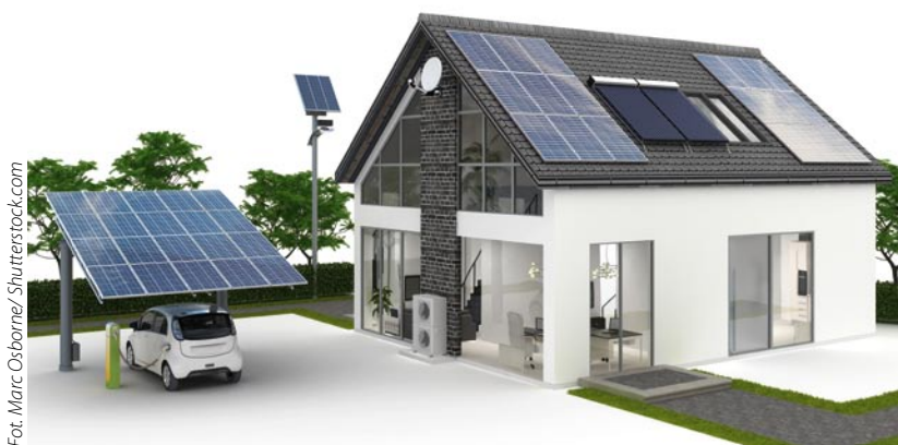
Rys. 3. „Dom bez rachunków” to budynek plus energetyczny, wykorzystujący także pasywnie energię słoneczną. Rozwiązanie jest przygotowane na ładowanie samochodu elektrycznego
